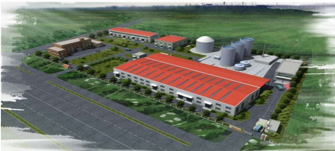
铜陵餐厨垃圾处理二期工程（在建）
